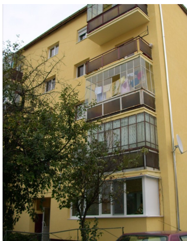
Reabilitare termică la un bloc din Alba Iulia
