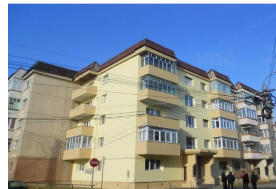
Fig. 6. Bloc situat pe strada Tabacari, reabilitat integral cu Certificat de Performanta Energetic (CPE)
