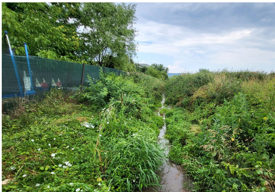
Imagine 4.7 Canal colector în aval de str. Calea Moșilor
