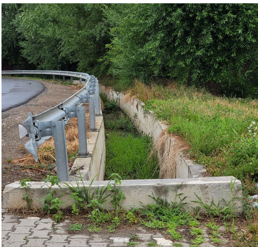
Imagine 5.14 Canal colector HC762 la intersecția str. Scărișoara cu str. Carpați
