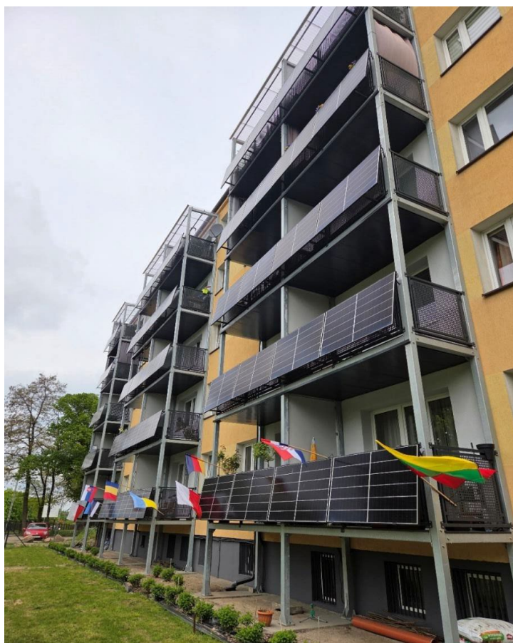
Figura 2. Partenerii CEESEN-BENDER vizitând o clădire renovată în Szczycno (Polonia) în mai 2025
