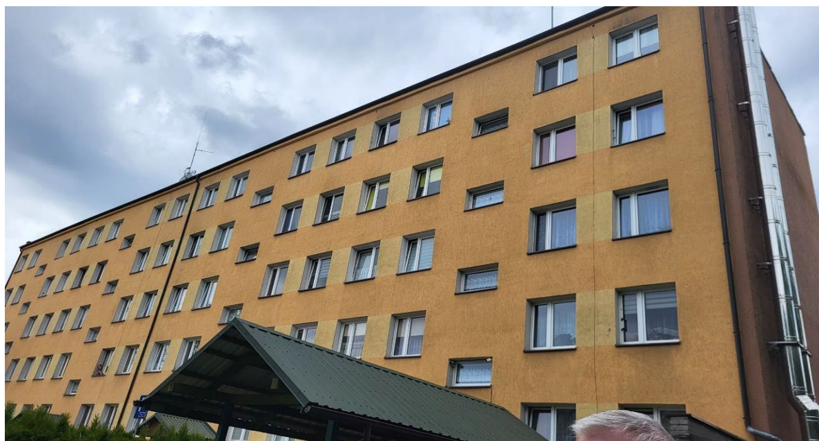
Figura 4. Partenerii CEESEN-BENDER vizitând o clădire renovată în Szczytno (Polonia) în mai 2025
